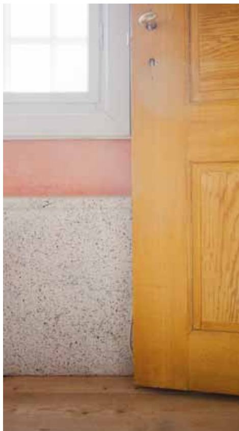
Her ses eksempel på en annen teknikk; Brystpanelet på veggen er stenk malt. En teknikk som er mye brukt i Sverige. Til stenkmalning benyttes gjerne limfarge eller eggoljetempera.
