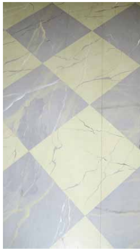
Detalj av det marmorerte gulvet i havestuen. Slike sjakkmonstrede gulv imiterer hollandske keramikkliser. Gulvet er malt med linolje og oljet med Bioimpression fra Ottoson som herder til hardt.
