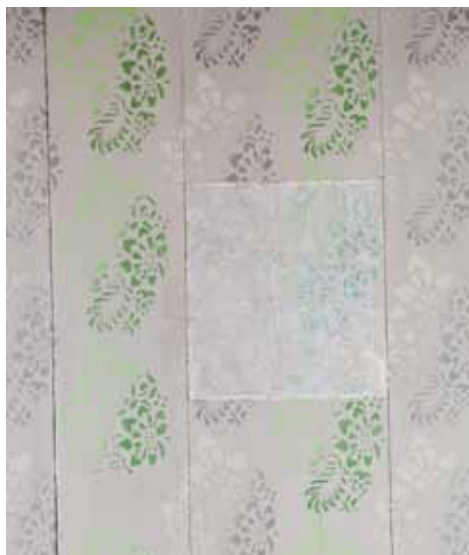
Sjablongtapetet i havestuen er en imitasjon av damasktapet. Originalt felt er bevart midt på.
